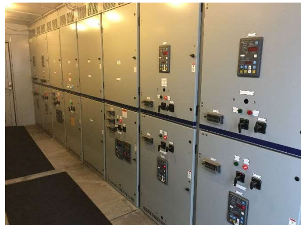
13.2-kV Feeder Switchgear
